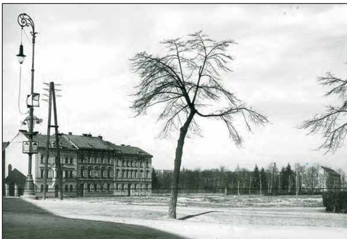
Prostor staveniště krajského soudu a věznice v Hradci Králové (foto: Fotoarchiv Muzea východních Čech)
