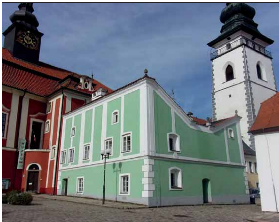
Bývalá městská šatlava a stará okresní soudní věznice v Pelhřimově (foto: archiv autora)
